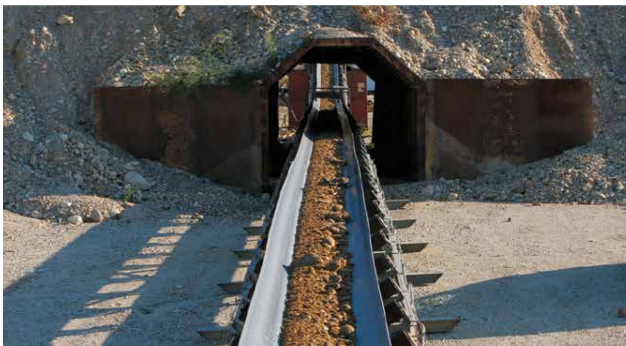
Une bande transporteuse achemine les granulats vers les installations de traitement.
