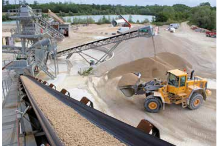
Vue d'ensemble des installations de traitement d'un site de granulats alluvionnaires
