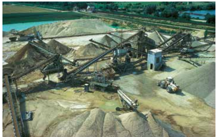
Installation de traitement dans une carrière de granulats alluvionnaires
