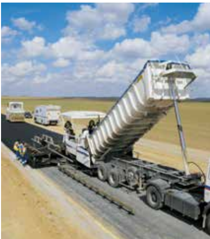
Mise en place d'une couche de roulement sur une nouvelle route
