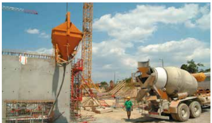
Livraison du béton sur chantier
