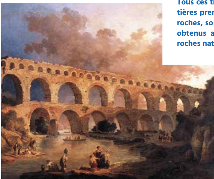
Le pont du Gard (peint par Hubert Robert en 1787)
