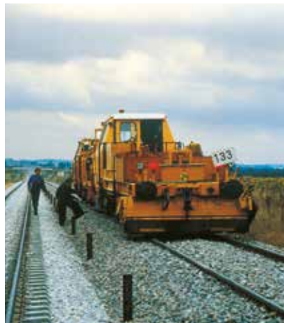
Pose de ballast sur la ligne du TGV Atlantique
