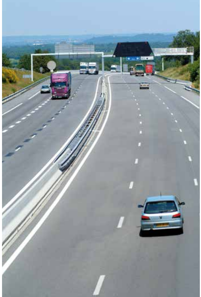
L'autoroute A 432, dans le département du Rhône
