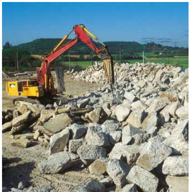
Recyclage : production de granules issus de béton de démolition
